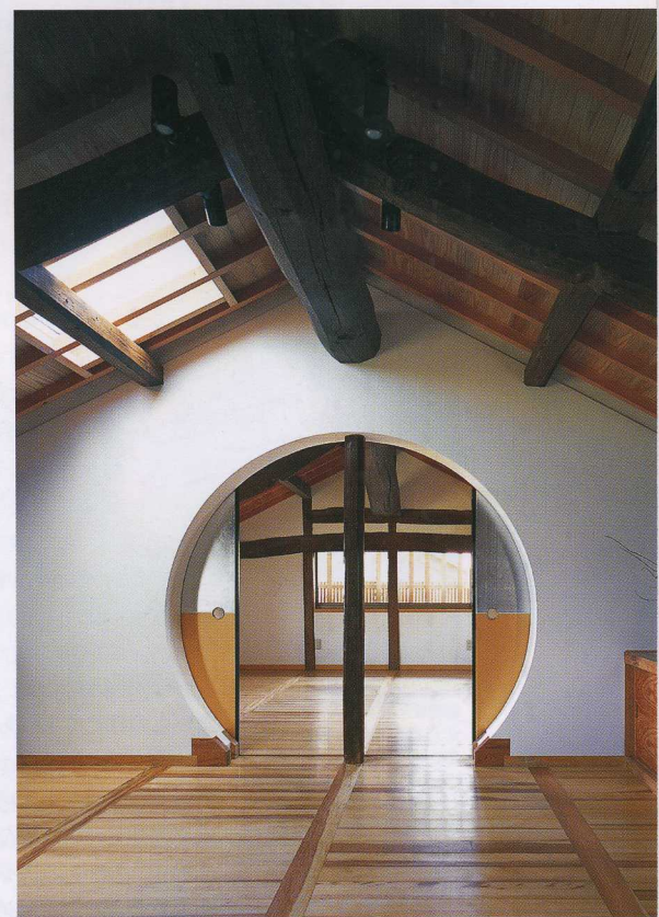
加須山の納屋 再生では既存の耐力壁の量を減らすことなく開口部を設けられる天窓による採光が有効。新設の間仕切壁は梁間方向の耐力壁としても働く。
